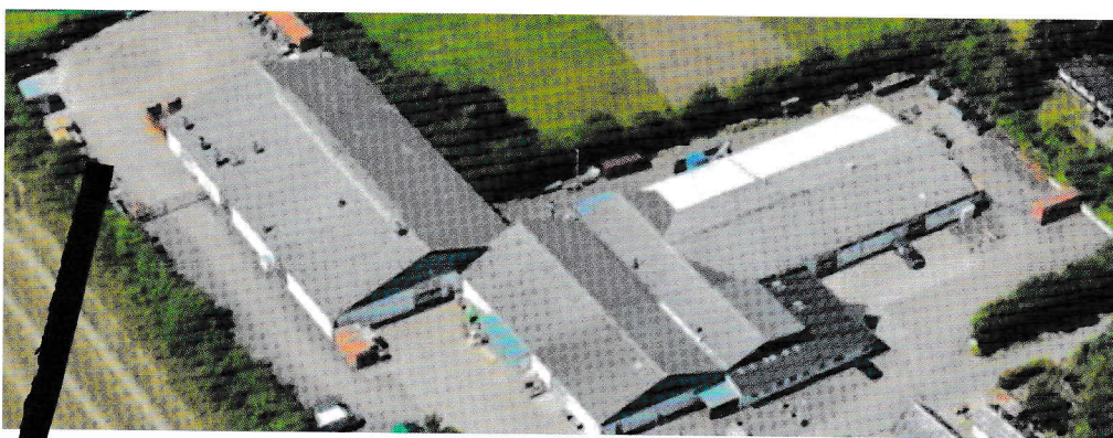
Luftfoto af hovedfabrikken i Øster Starup. (Foto: ECM Industries A/S).
